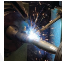
Spawanie połączenia zaworu kulowego i rury stalowej
