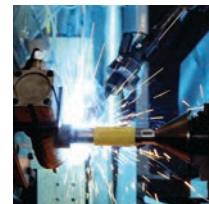
Zgrzewanie połączenia węzła ze stali szlachetnej z izolowaną rurą stalową
