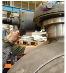
Montaż kurka kulowego
