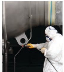
Wykonanie powłoki zabezpieczającej kurek
